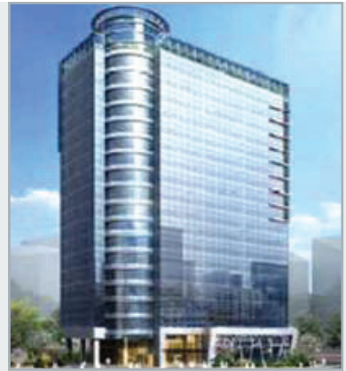
❁ 미근동 업무용 빌딩
