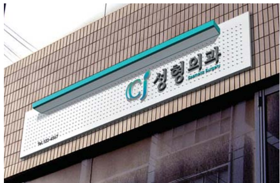
타일마감 외장 마감재가 깔끔하지 않을 경우 평형간판 적용
